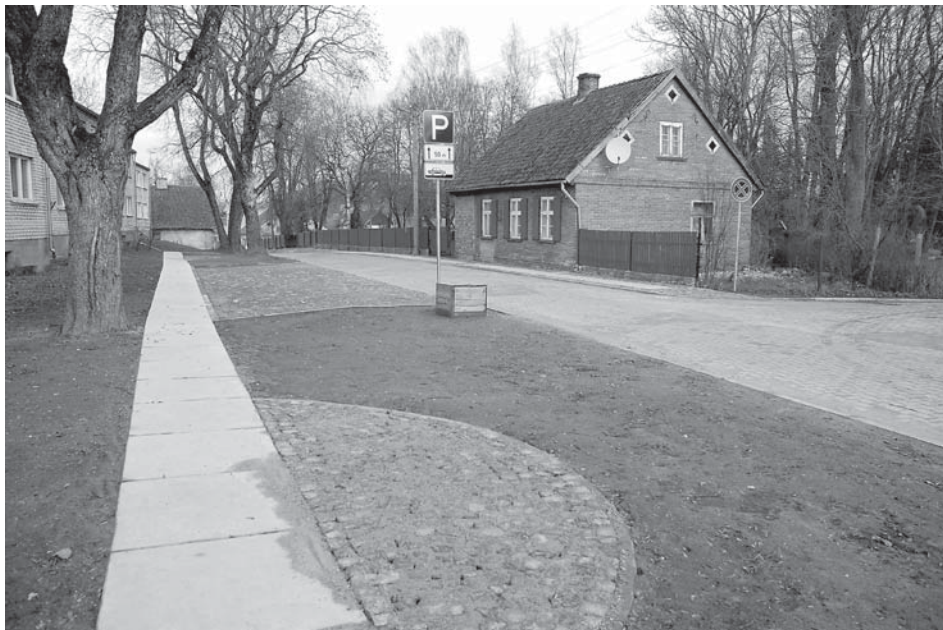
Līdz nepazīšanai pārvērtusies Annas iela. Brauktuvē ieklāts betona bruģis ar granīta šķembām. Izveidotas jaunas ietves, kuras klāj baltas betona plāksnes. Ierīkota automašīnu stāvvietā.
