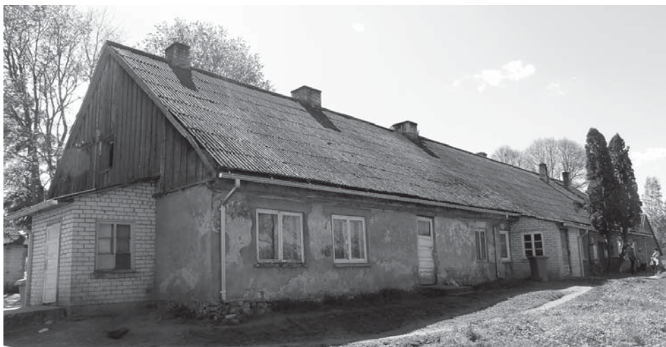
Padures „Ūšas” pirms un pēc apjomīgajiem remontdarbiem.
