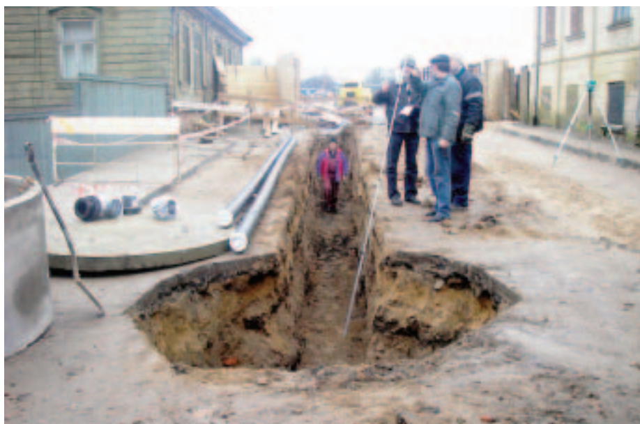
Rokot tranšeju tilta kanalizācijas ierīkošanai Kalna ielā 23 pie tilta uzbrauktuves, zemes darbus uzraudzījis arheologs.
