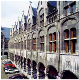
1. La première cour. The first courtyard. © Région Wallonne/ G. Focant.
